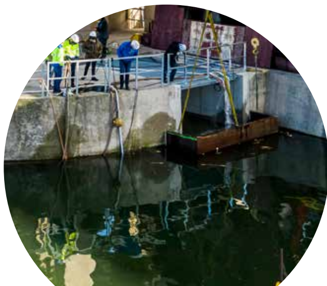
Enlèvement du caisson étanche de l'exutoire en mars 2021, complétant le dispositif mis en place sur la centrale hydro-électrique de Grands-Malades.
