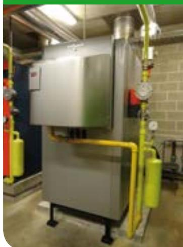
En novembre 2014, le bâtiment administratif du site de Seraing s'est équipé d'une nouvelle chaudière à condensation pour le chauffage des locaux. Le modèle retenu permet de réduire au maximum les émissions associées. L'échangeur est en acier inoxydable ce qui permet de réduire la corrosion et de prolonger la durée de vie de l'installation.
