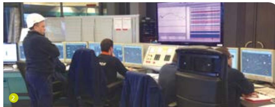
2 La salle de commande de la centrale de Seraing. Ce cycle combiné est une unité de production « black start » qui peut démarrer sans être alimentée en électricité via une source externe, grâce aux moteurs diesel dont elle est équipée. Ces moteurs sont régulièrement démarrés pour test.
